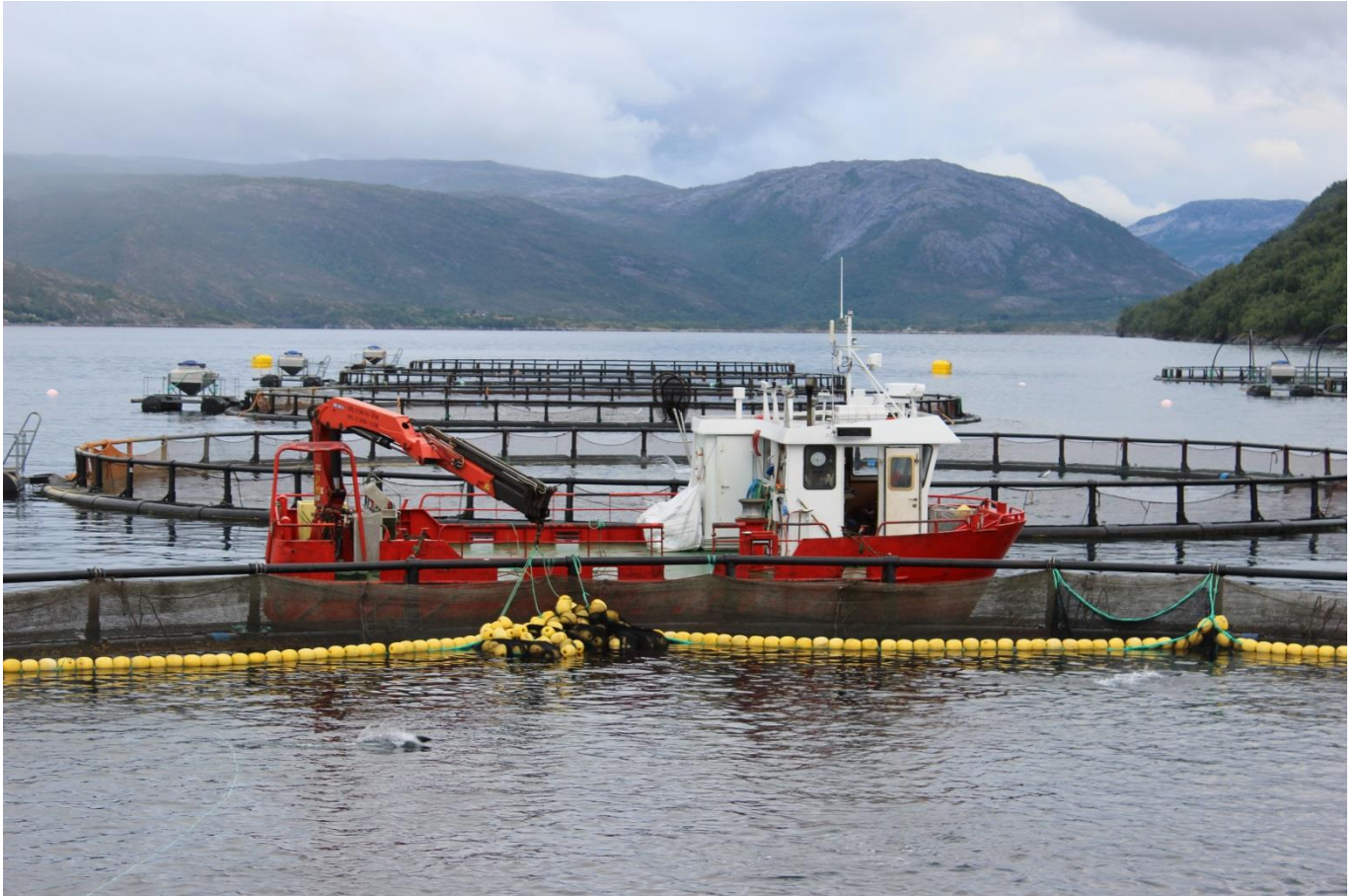
Figur 3: Montering av luseskjørt.
